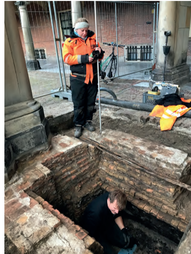
Archeologisch onderzoek tijdens de renovatie.
