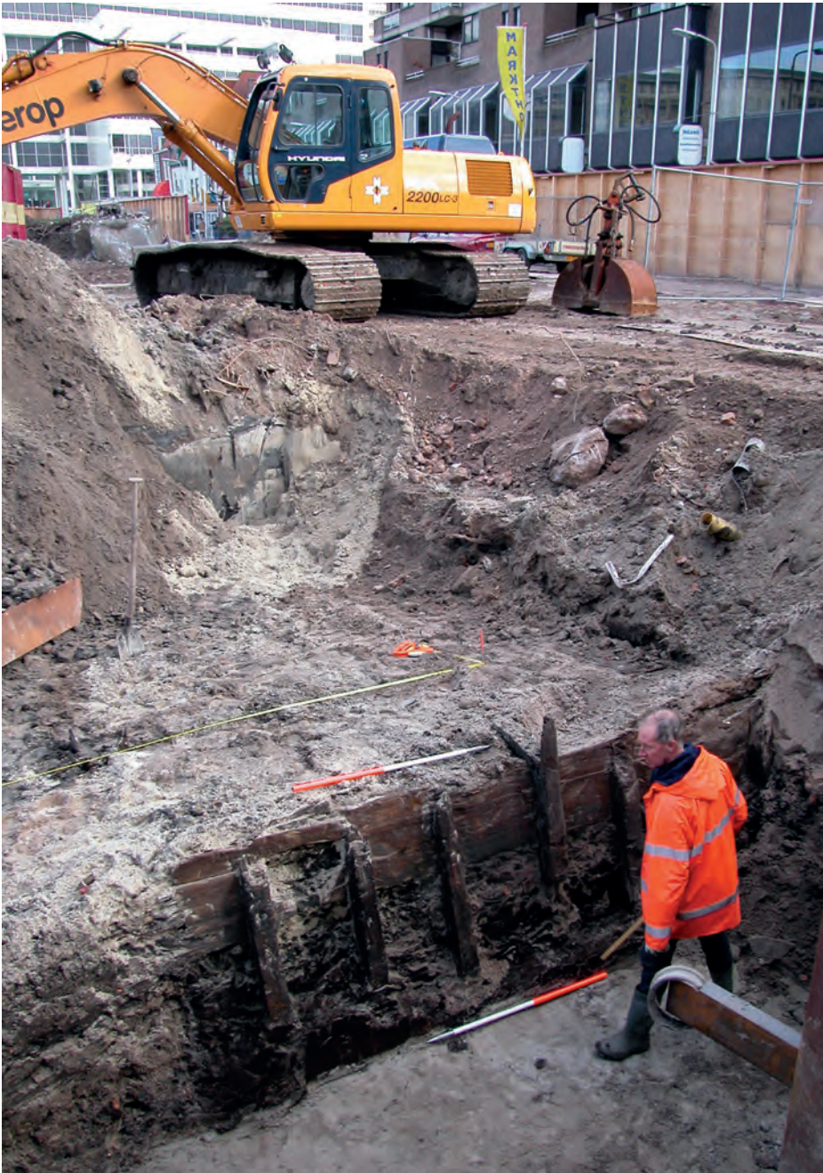
De beschoeiing van de Voldersgracht bij een archeologisch onderzoek in 2004.
